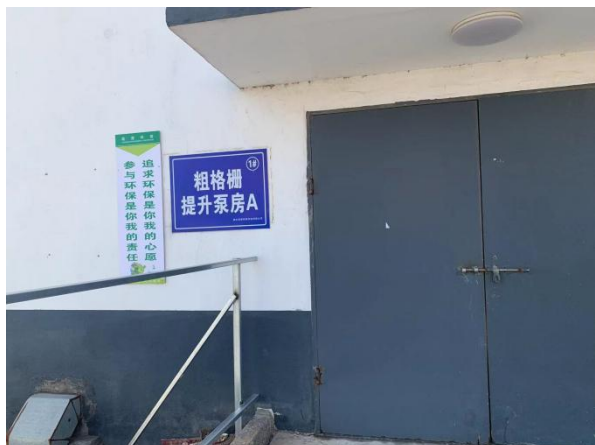
粗格栅/进水泵房
