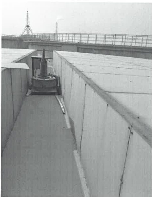
加盖收集装置
